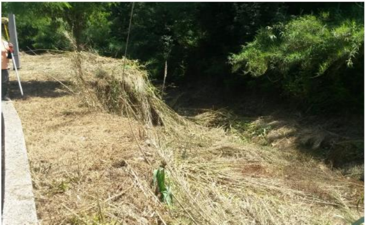
Vista del vallone Torricelli in sinistra idraulica – Sponda sottotrada
