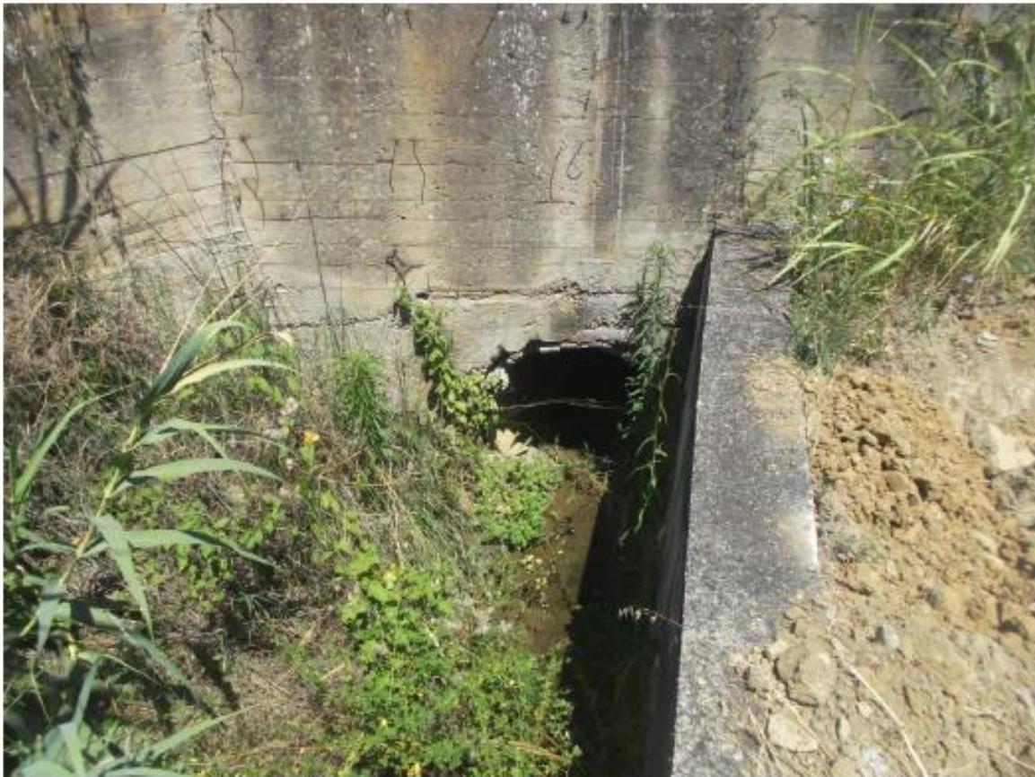
Particolare dell'attraversamento T7
