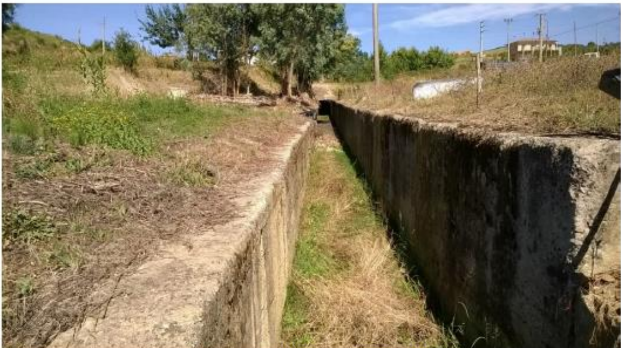
Particolare dell'attraversamento T14
