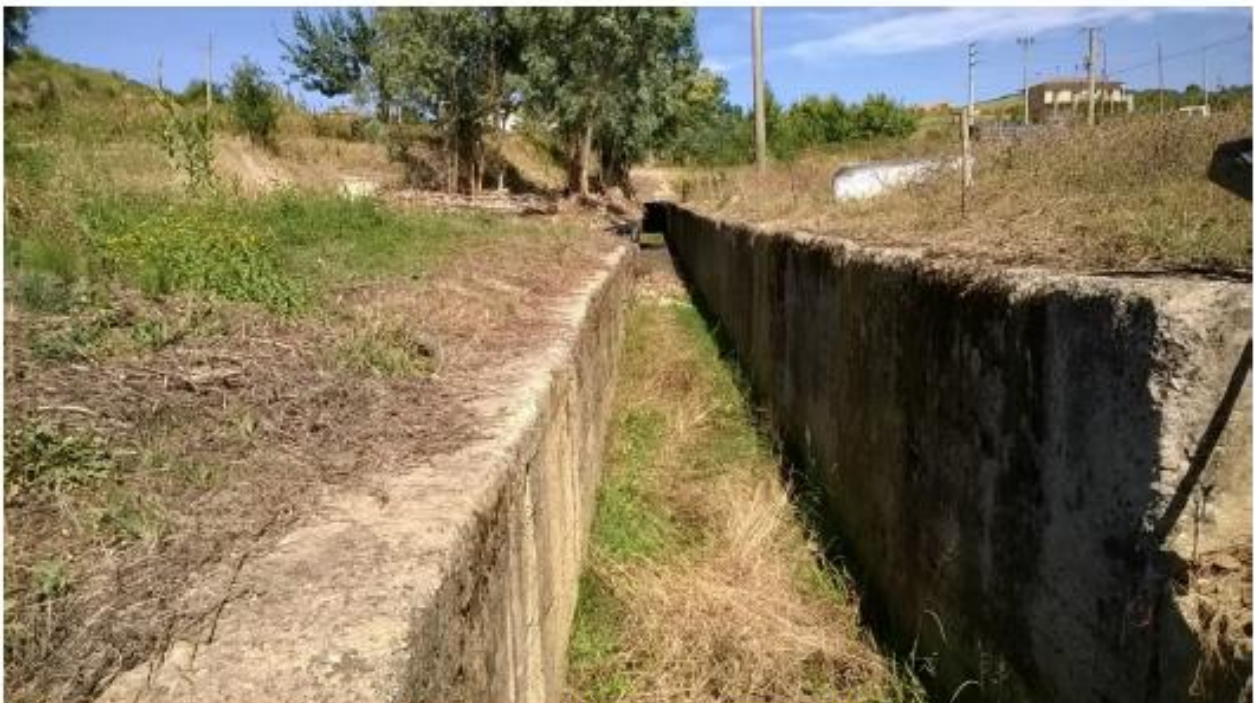
Particolare dell'attraversamento T14
