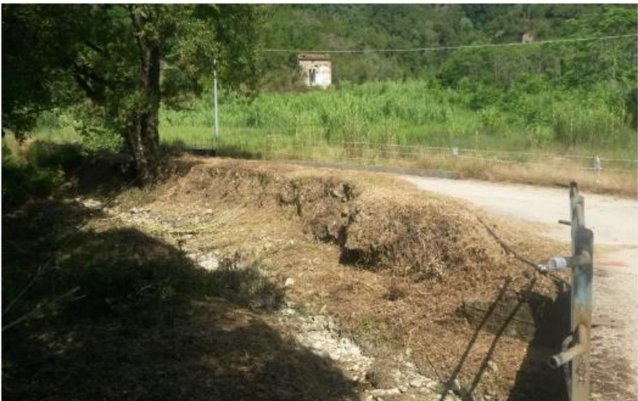
Vista del vallone Toricelli in sinistra idraulica – Sponda prossima all'attraversamento
