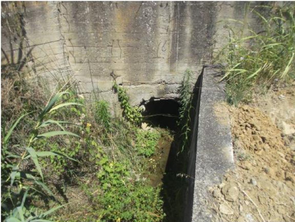
Particolare dell'attraversamento T7
