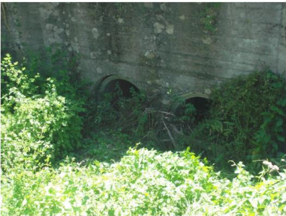
Particolare dell'attraversamento T6
