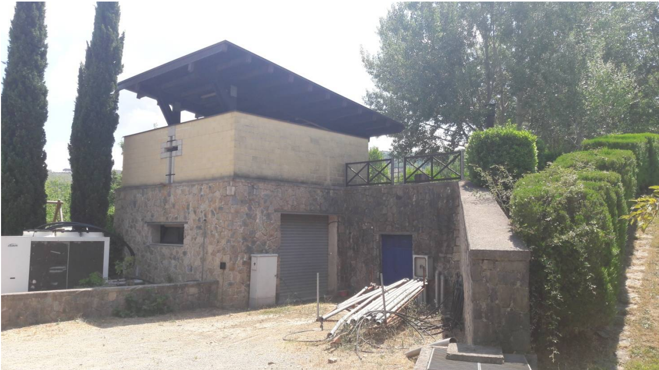
Centrale MDV (vista ovest) - Stato di fatto
