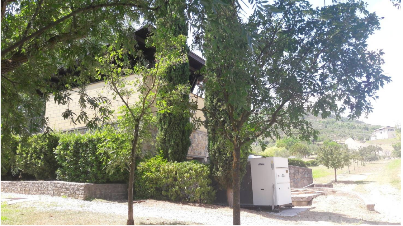
Centrale MDV (vista ovest) - Stato di fatto
