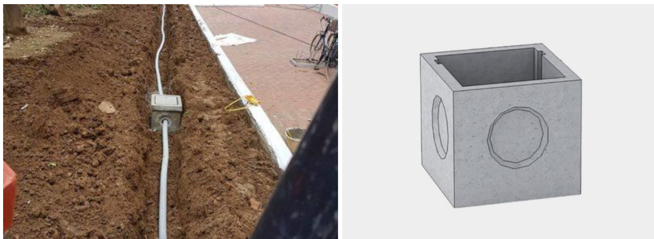
Figura 3 Esempio di posa cavidotto (sinistra) e di pozzetto prefabbricato (destra)
