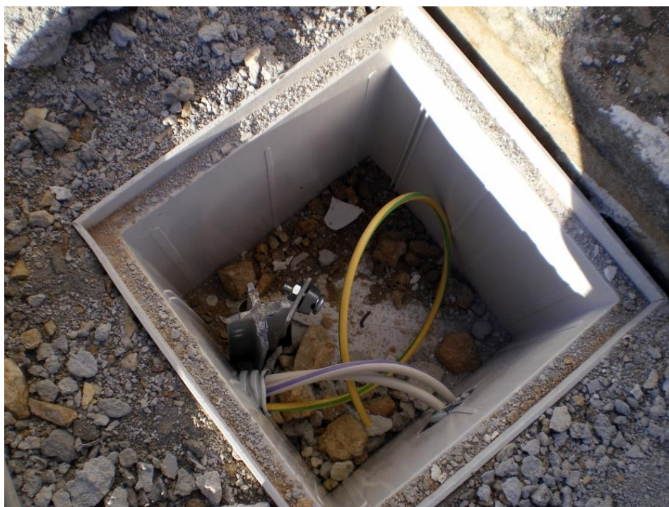
Figura 7 Esempio di messa a terra con picchetto dispersore
