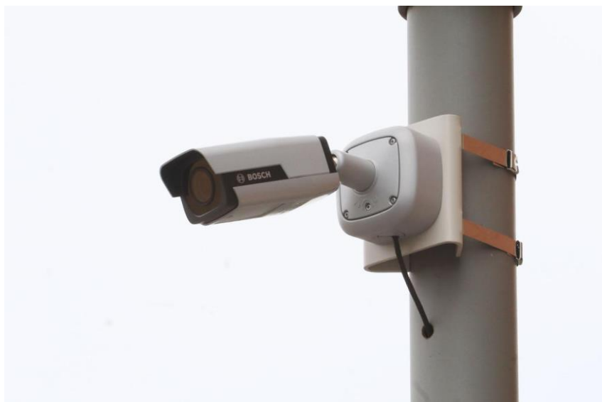
Figura 13 Esempio di telecamera fissata al palo
