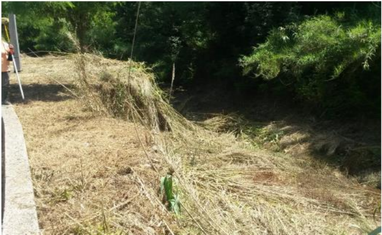
Vista del vallone Torricelli in sinistra idraulica – Sponda sottostrada
