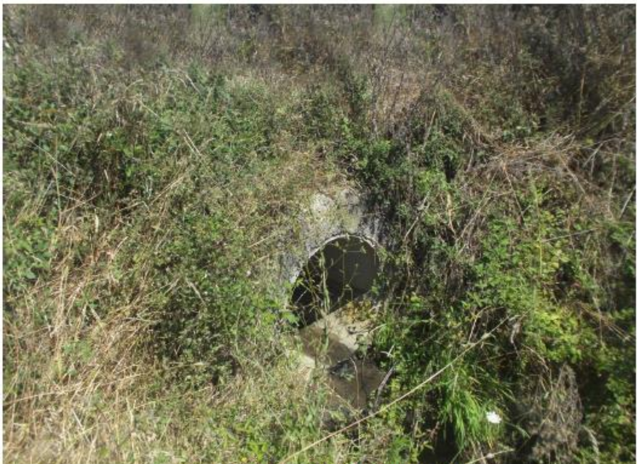
Particolare dell'attraversamento T9
