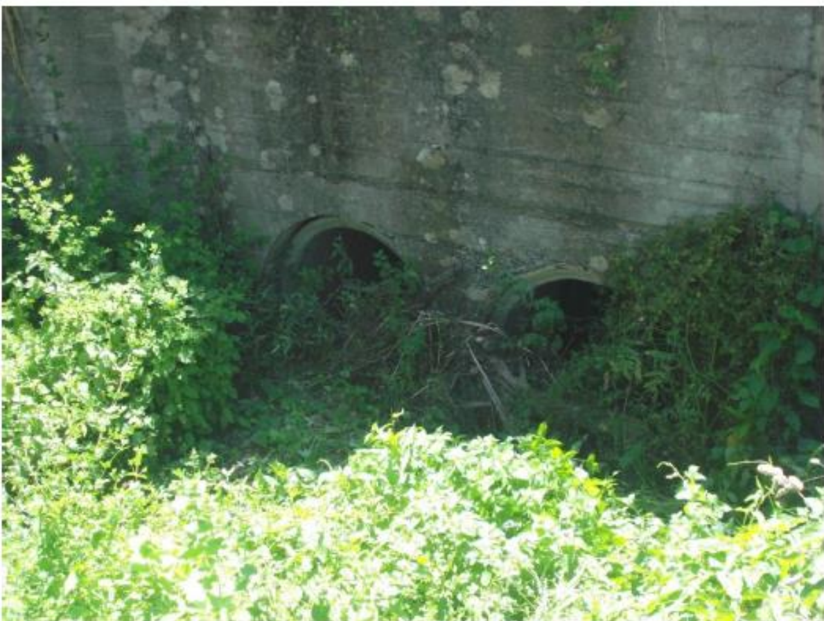
Particolare dell'attraversamento T6
