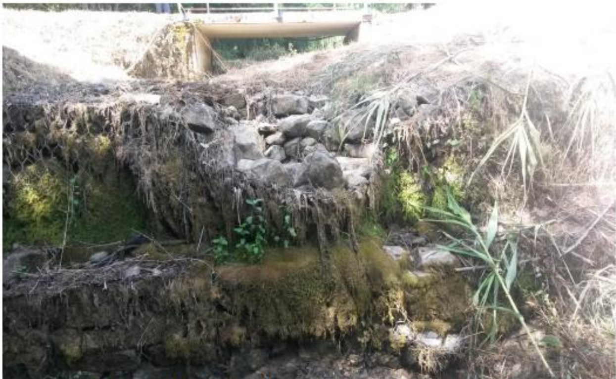
Vista della briglia e dell'attraversamento sul vallone Torricelli
