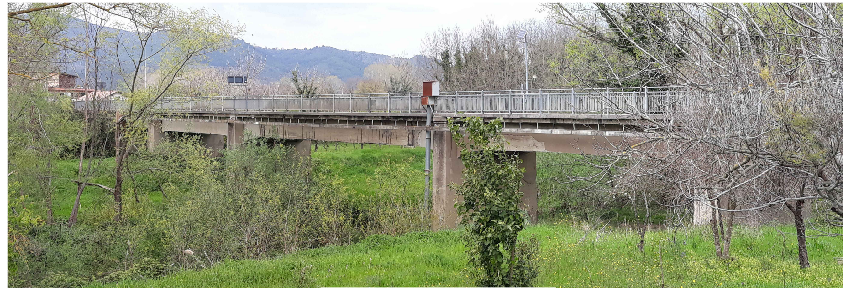
Vista fotografica del ponte esistente da sud - est
