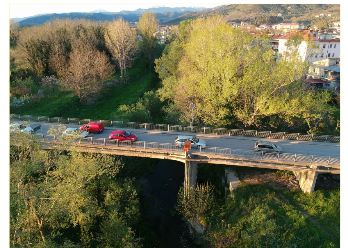
Panoramica da sud del ponte sull'Alento
