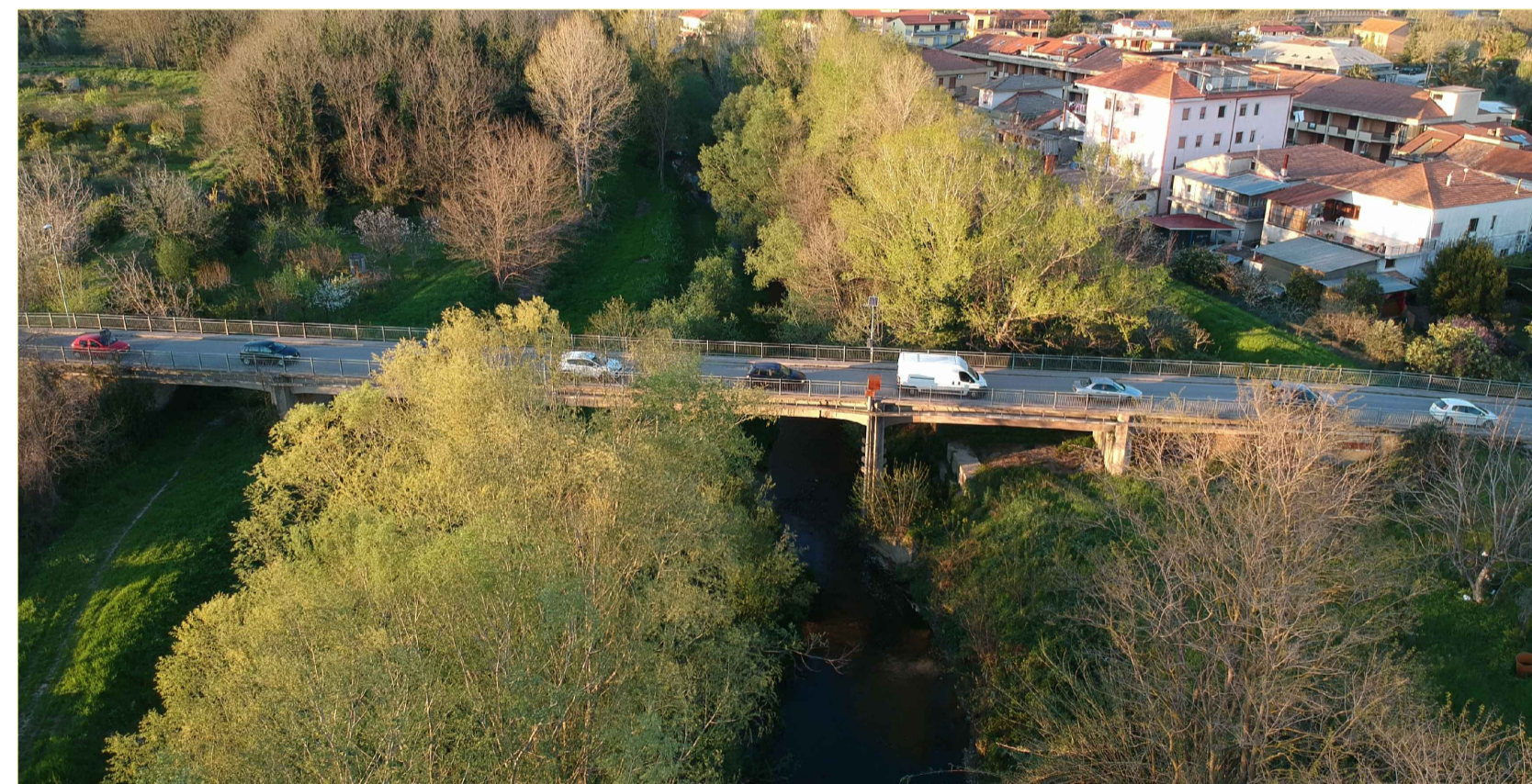
Vista aerea da sud
