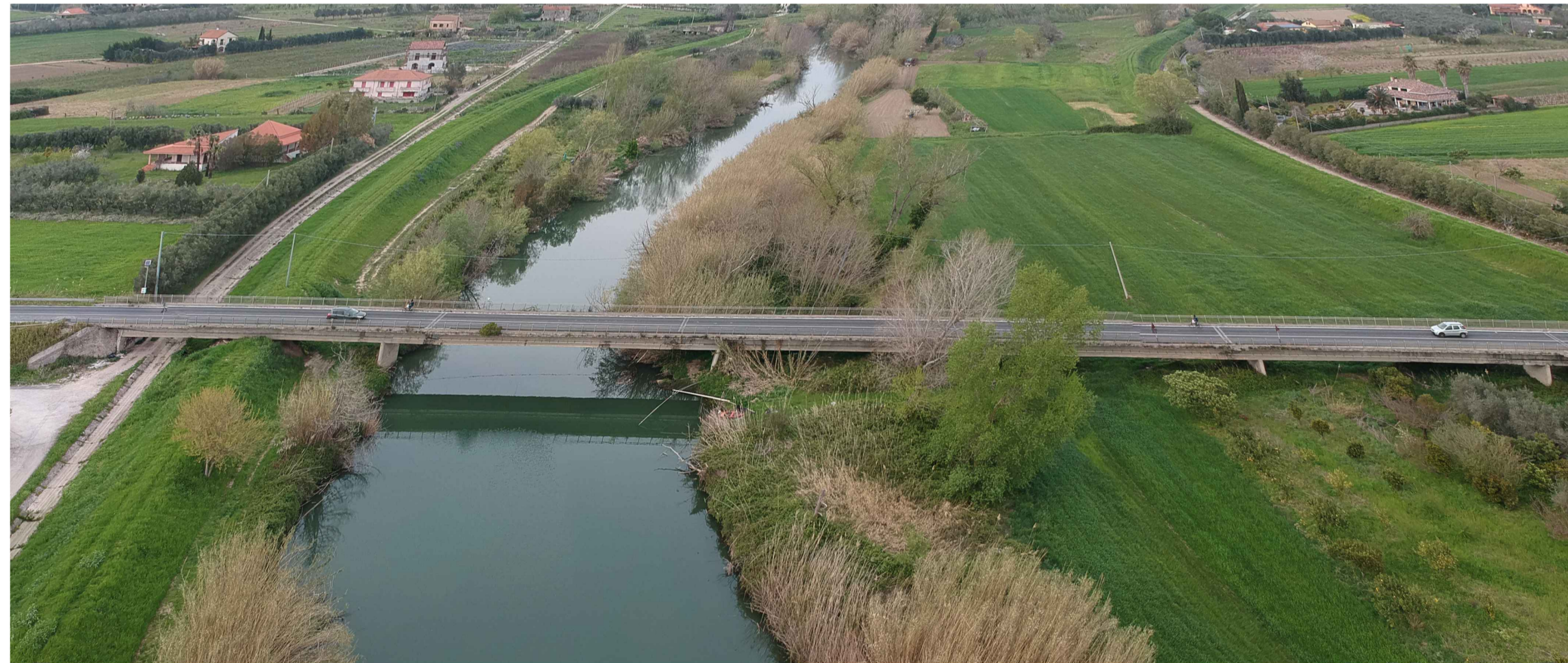
Vista del ponte esistente dalla località Foce
