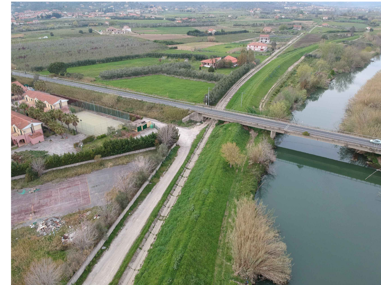
Vista panoramica da sud
