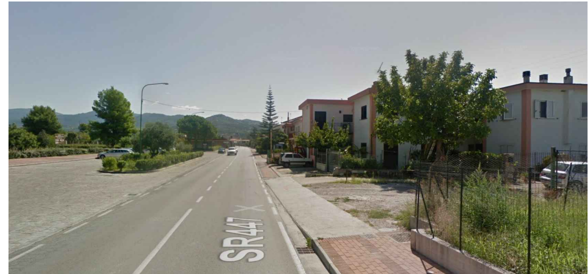
Applicazione in corrispondenza dell'incrocio di passo ciclopedonale / zebratura eseguita mediante applicazione di vernice rifrangente premiscelata di colore bianco permanente. La relazione della segnaletica verticale è demandata a un successivo lotto esecutivo.
