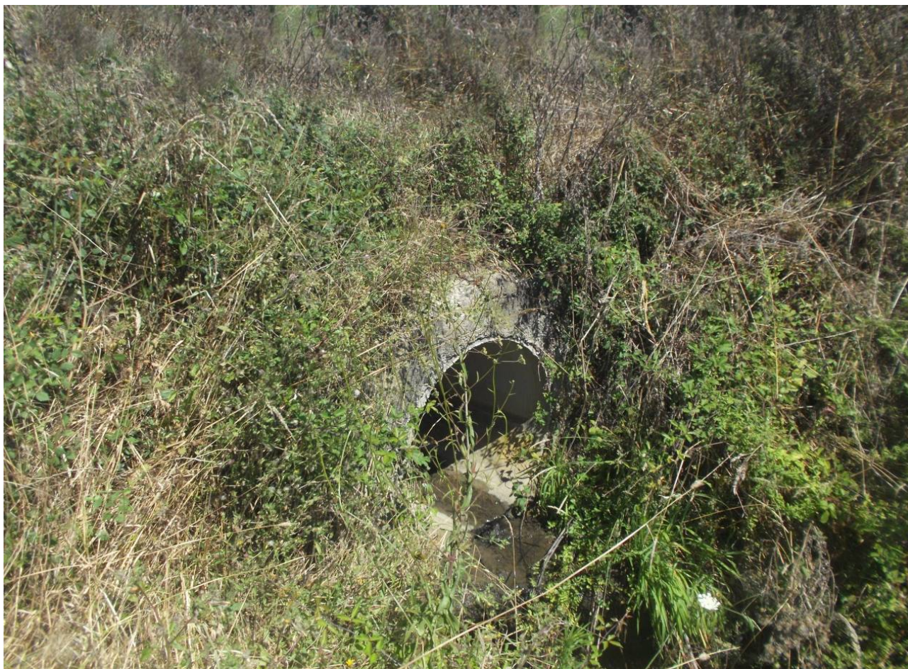
Particolare dell'attraversamento T9
