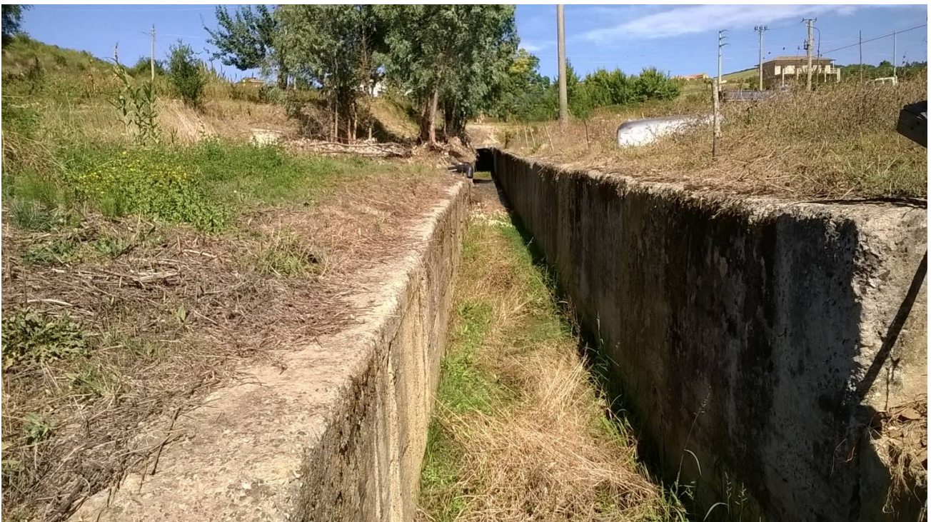
Particolare dell'attraversamento T14
