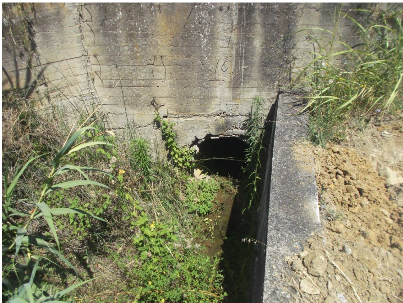
Particolare dell'attraversamento T7
