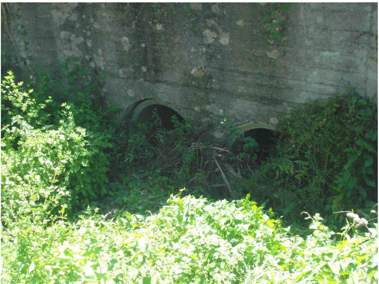
Particolare dell'attraversamento T6
