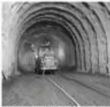
Figura 5: Preconsolidamento del fronte
