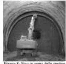
Figura 8: Posa in opera delle centine
