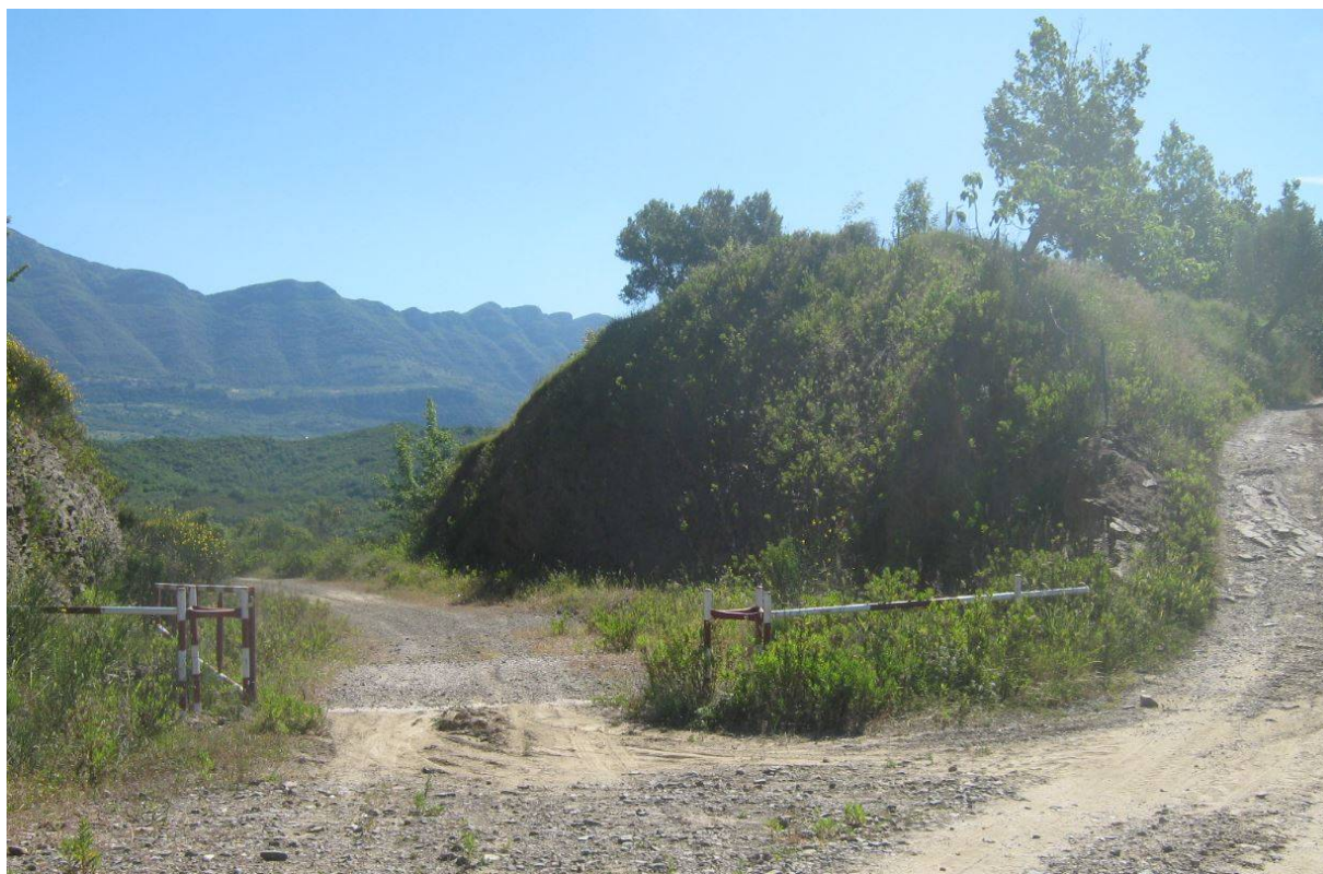
Tratto ex – galleria
